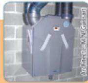
Le système D avec récupération de chaleur est vivement conseillé. C'est le système le plus performant : grâce à un échangeur, il permet de récupérer jusqu'à 90% de la chaleur contenue dans l'air rejeté.
